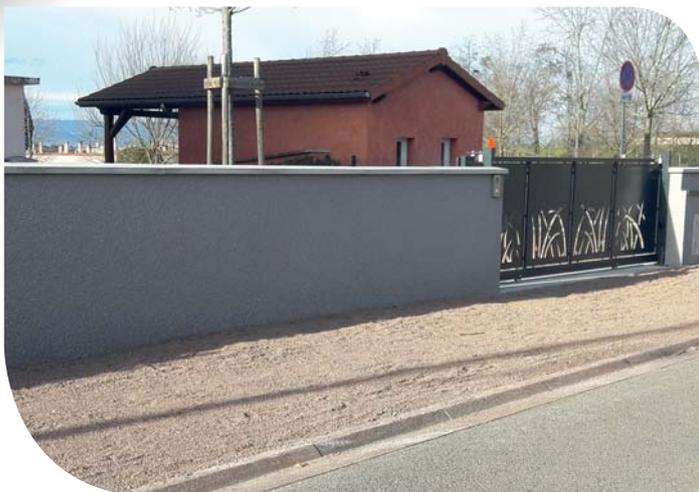
Le mur nécessitait un ravalement, toutefois les infiltrations d'eau à l'intérieur de celui-ci ne permettaient pas de se contenter d'un simple recrépissage. L'entreprise DE BELLIS de Mably a donc procédé à la démolition complète puis à la construction d'un nouveau muret. Seule la partie intégrant les coffrets techniques (électricité, gaz et téléphone) a été maintenue pour des raisons de coût et de sécurité.
